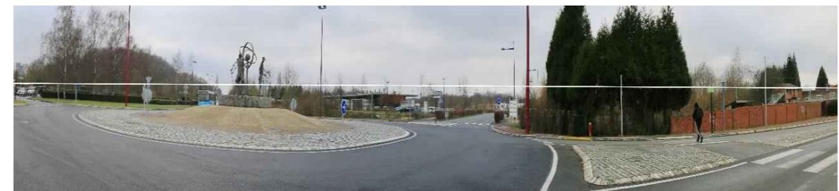
Horizon concave lié à une mauvaise mise à niveau de l'appareil (Le trait blanc est le niveau de référence)
